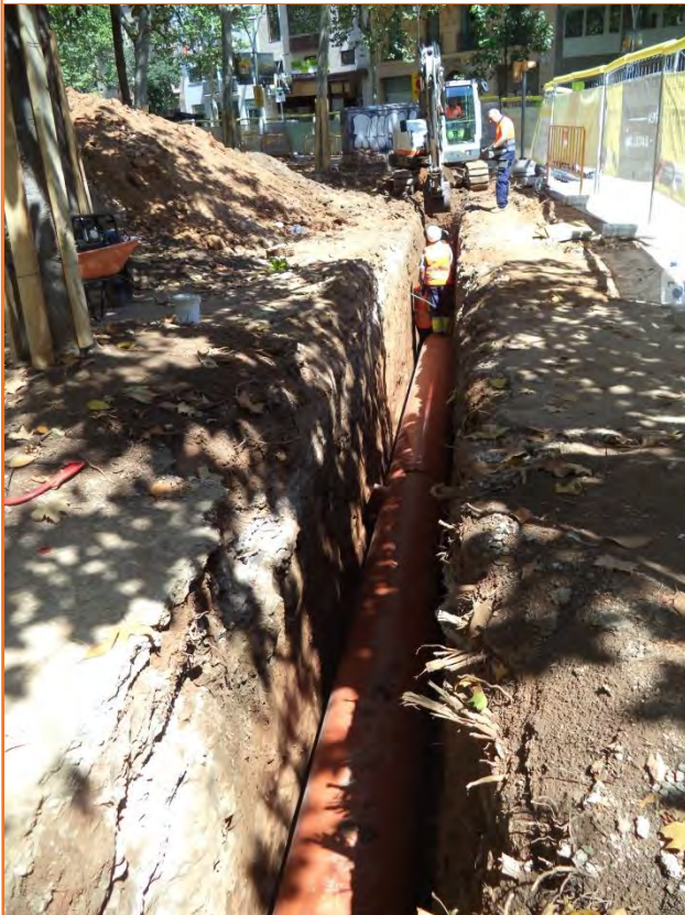
Foto 51. Vista de la rasa del col·lector del carrer Rocafort.
