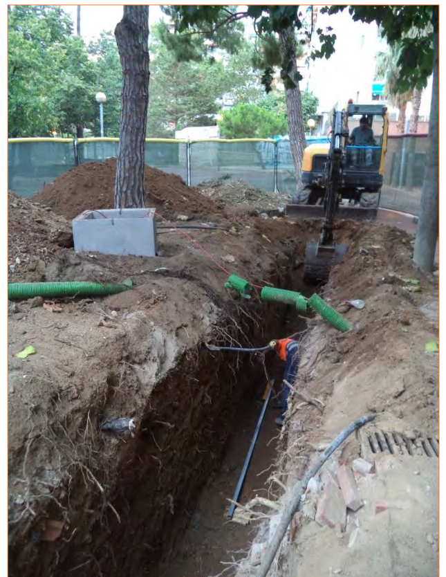
Foto 54. Vista de la rasa del col·lector del carrer Rosselló.
