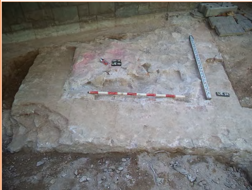
Foto 42. Vista fonamentació UE 98
