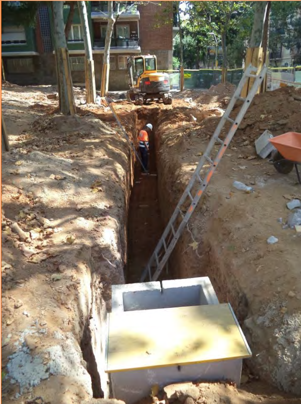
Foto 53. Vista de la rasa del col·lector del carrer Rosselló.
